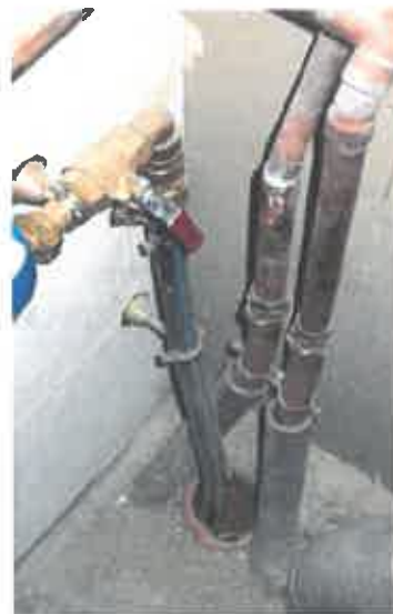
Calfeutrage des entrées de réseaux
