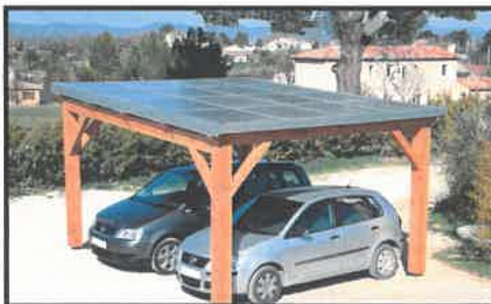
Construction annexe non contiguë
