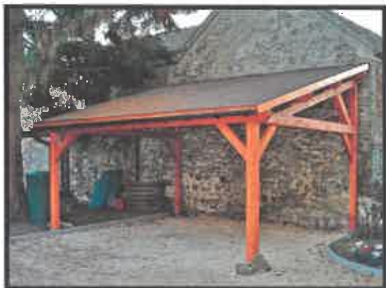
Construction annexe adossée
