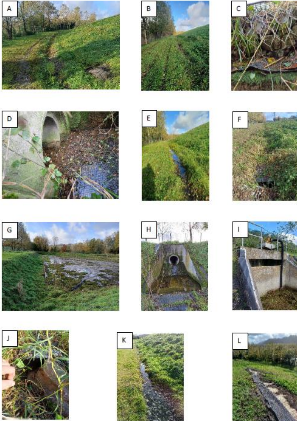
Figure 10. Planche de photos de la visite terrain
