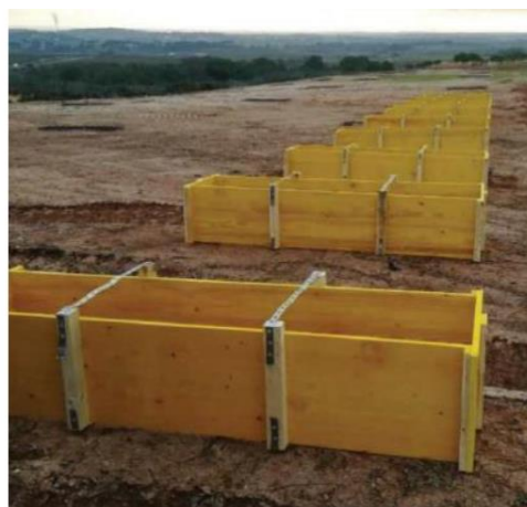
Figure 16 : Exemple de fondation béton type longrine coulées en place (Source : Eiffage Energie)
