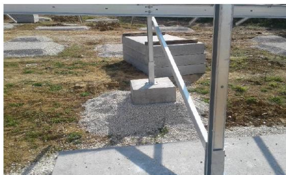
Figure 64 : Exemple de fondations béton préfabriquées (Source : EIFFAGE)
