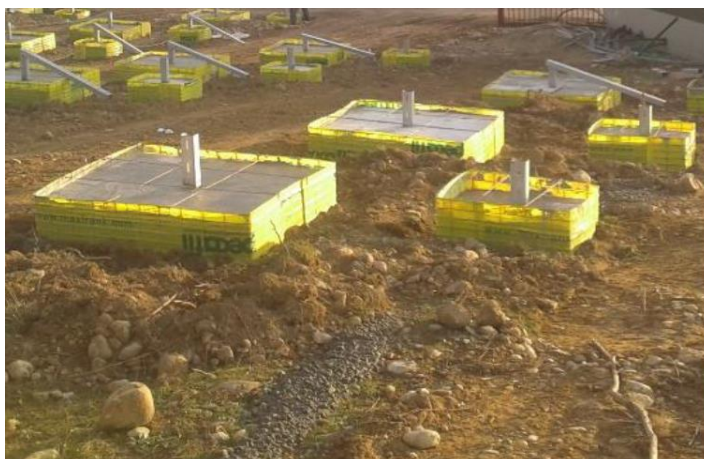
Figure 16 : Exemple de fondation béton type longrine coulées en place (Source : Eiffage Energie)
