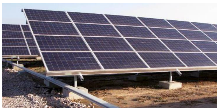
Figure 21 : Exemple de cheminement des chemins de câbles sur parpaings (Source : Eiffage Energie)
