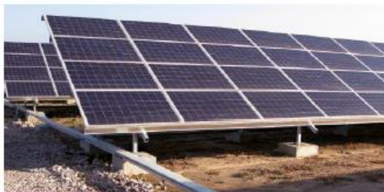
Mise en place des systèmes de supports et des panneaux, sans aucune incidence sur les sols
