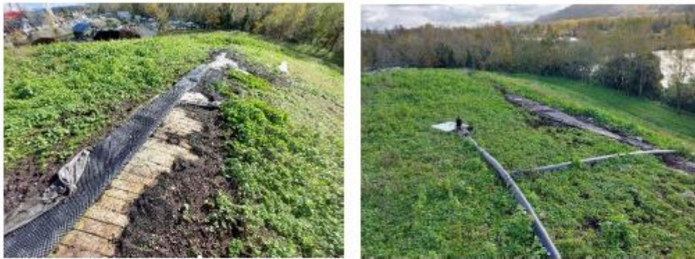
Figure 8. Zones érodées sur la couverture du dôme
