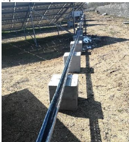
Figure 21 : Exemple de cheminement des chemins de câbles sur parpaings (Source : Eiffage Energie)
